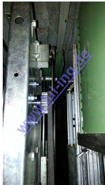
Abb. 11: TSG eingebaut - Sicht von oben
