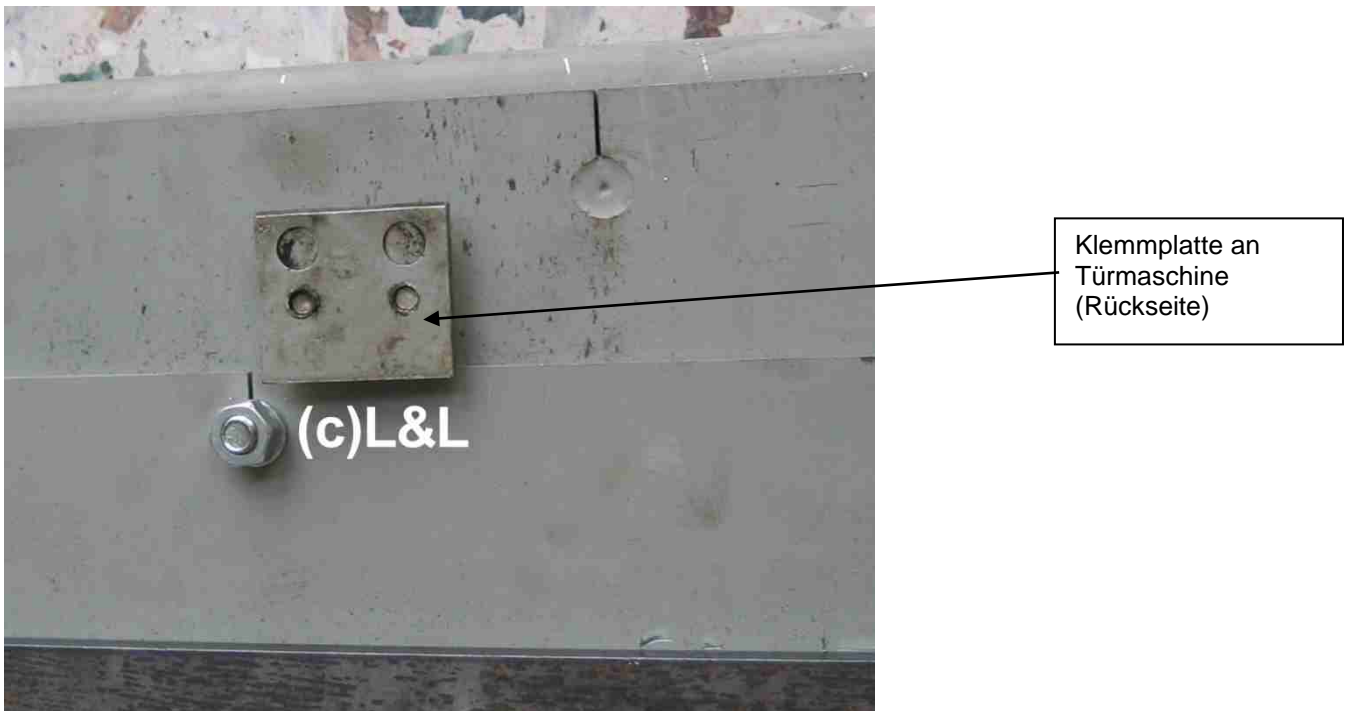
Abbildung 7: Klemmplatten an neuer Türmaschine
