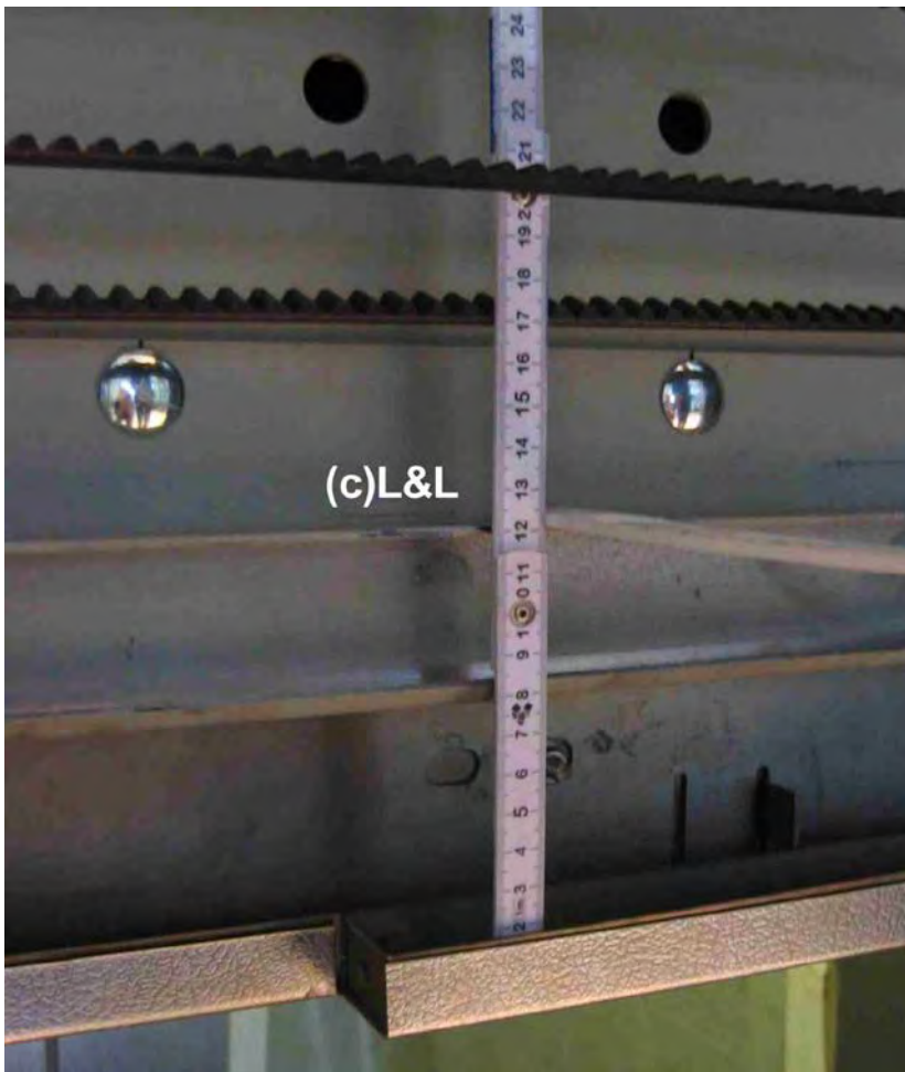
Abbildung 6: Höhe Laufschiene von Kabinendurchgang
