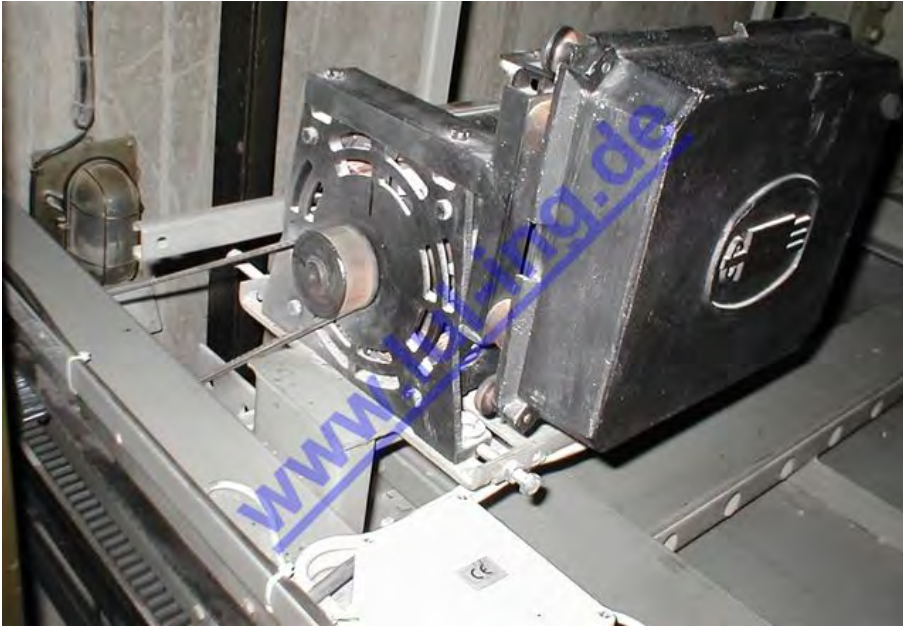
Abb. 2: Thyssen M2 vor dem Umbau: Antrieb
