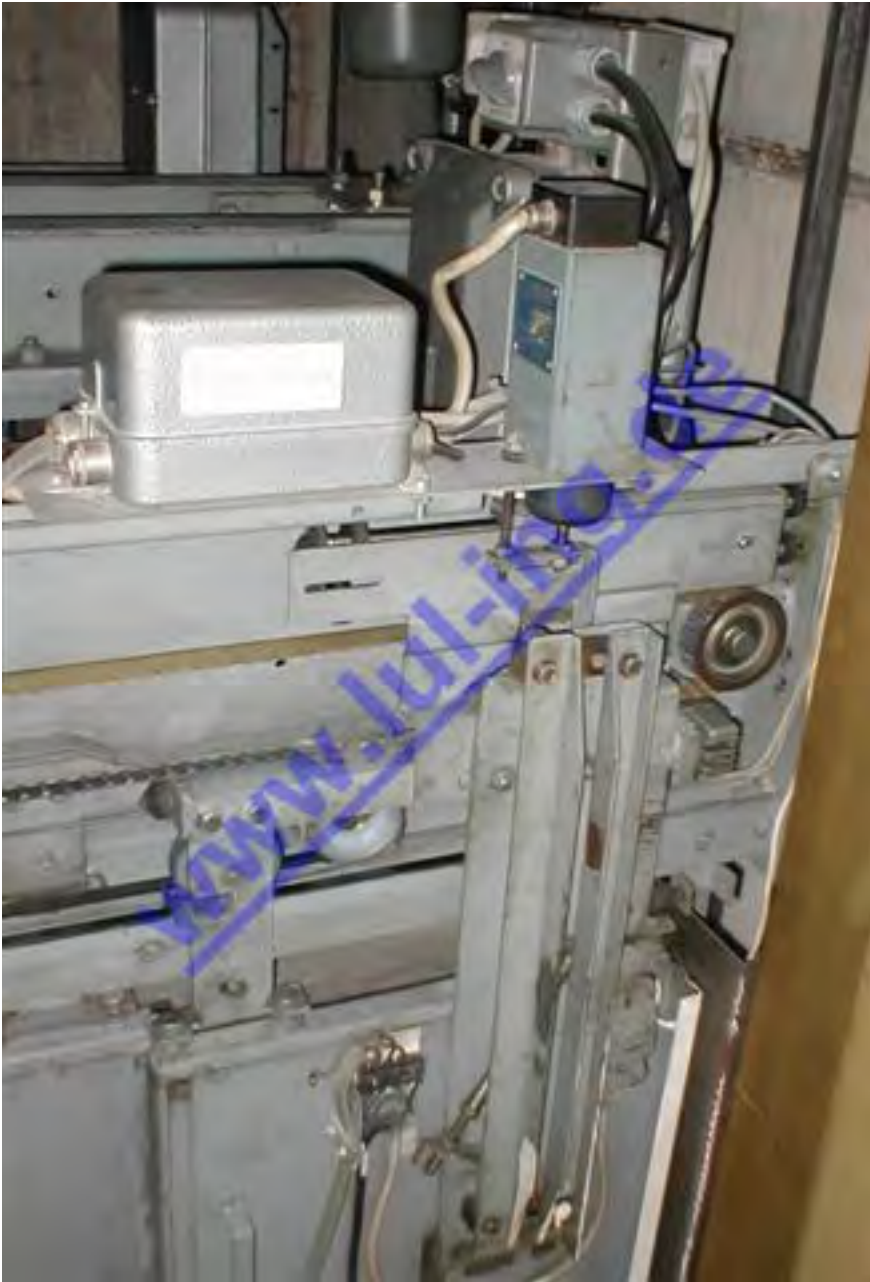
Abb. 1: Thyssen M2: Schließseite mit Magnet für Spreizschwert
