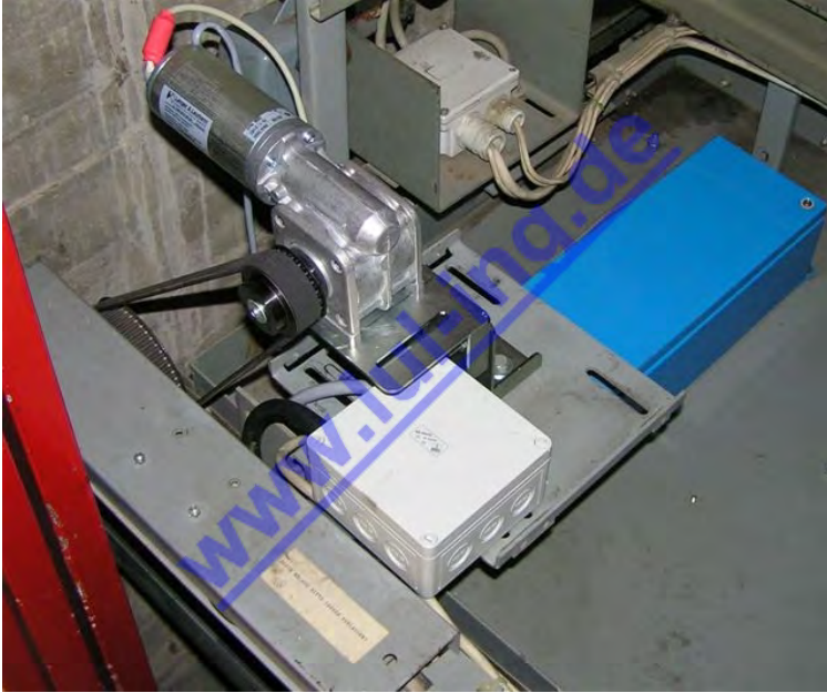
Abb. 6: Thyssen M2 nach dem Umbau: TSG Antrieb
