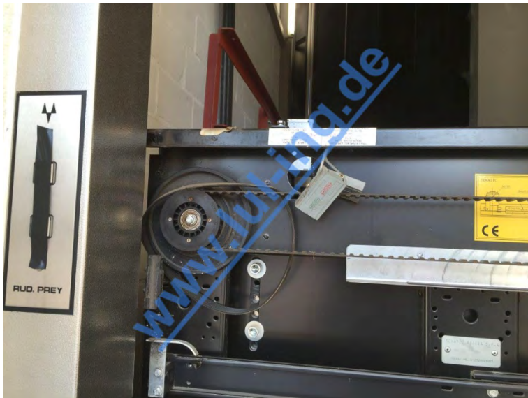
Abb. 4: Sematic Türmaschine vor dem Umbau (mit bereits demontiertem Sematic-Antrieb)
