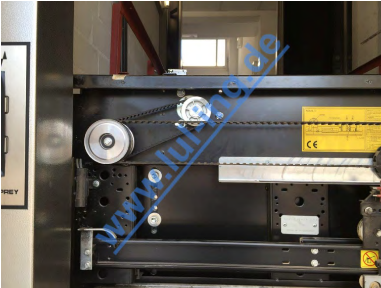
Abb. 12: fertig montierte Türmaschine mit TSG
