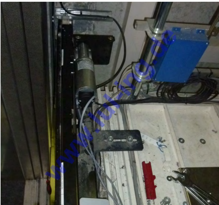
Abb. 15: fertig montierte Türmaschine mit TSG (zentral öffnend)
