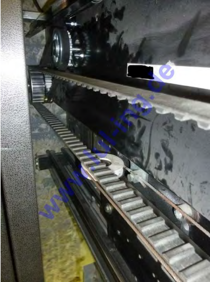
Abb. 14: fertig montierte Türmaschine mit TSG (zentral öffnend)
