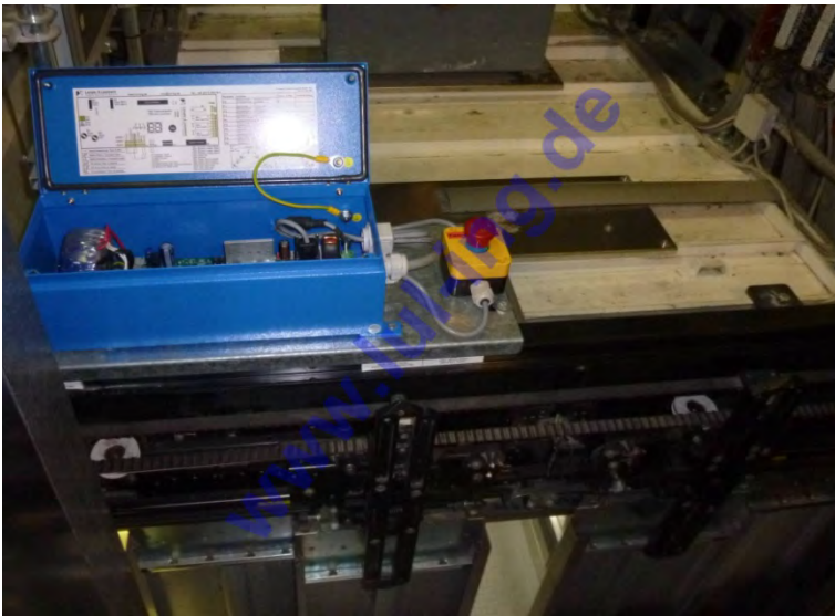
Abb. 16: fertig montierte Türmaschine mit TSG (zentral öffnend)
