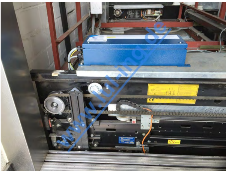
Abb. 17: fertig montierte Türmaschine mit TSG (rechts öffnend)
