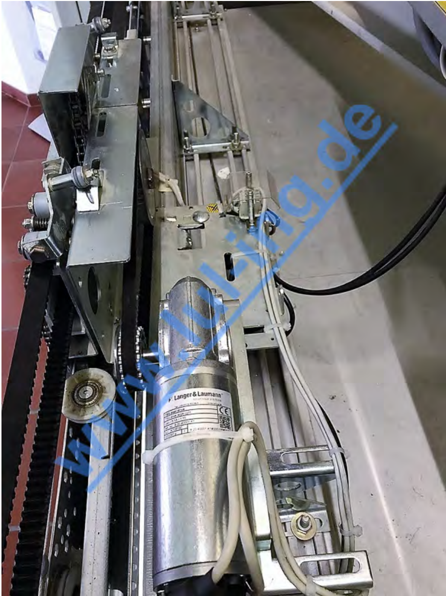
Abb. 10: fertig montierter TSG Antrieb
