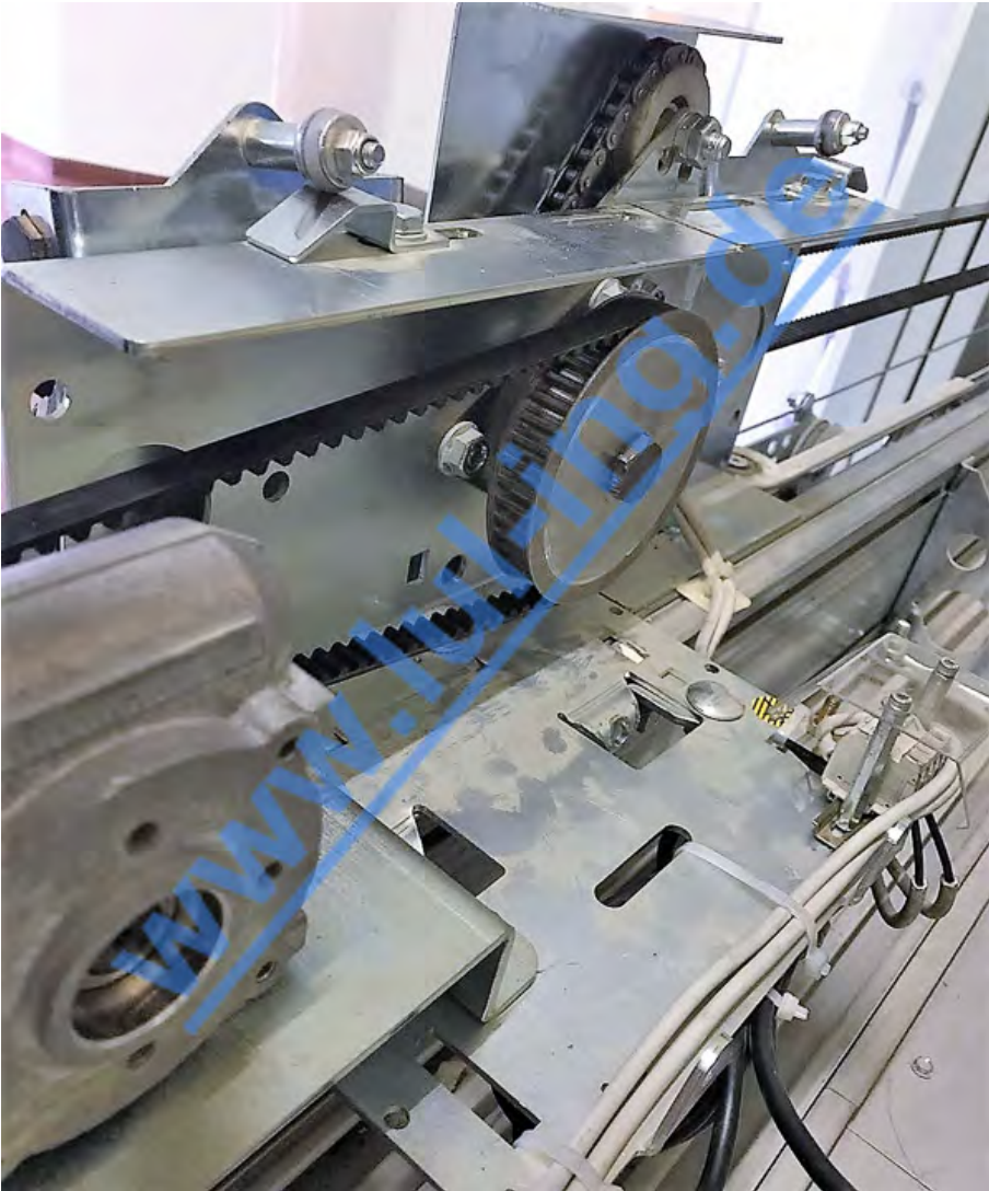
Abb. 13: fertig montierter TSG Antrieb
