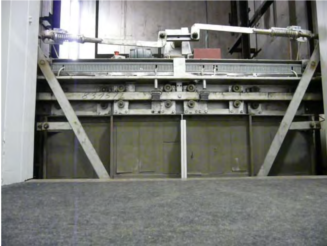
Abb. 1: Hiro Türmaschine vor dem Umbau - Ansicht von vorne (hier: Z)
