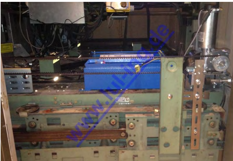
Abb. 5: TSG eingebaut in Otis 9550 (hier: TL)
