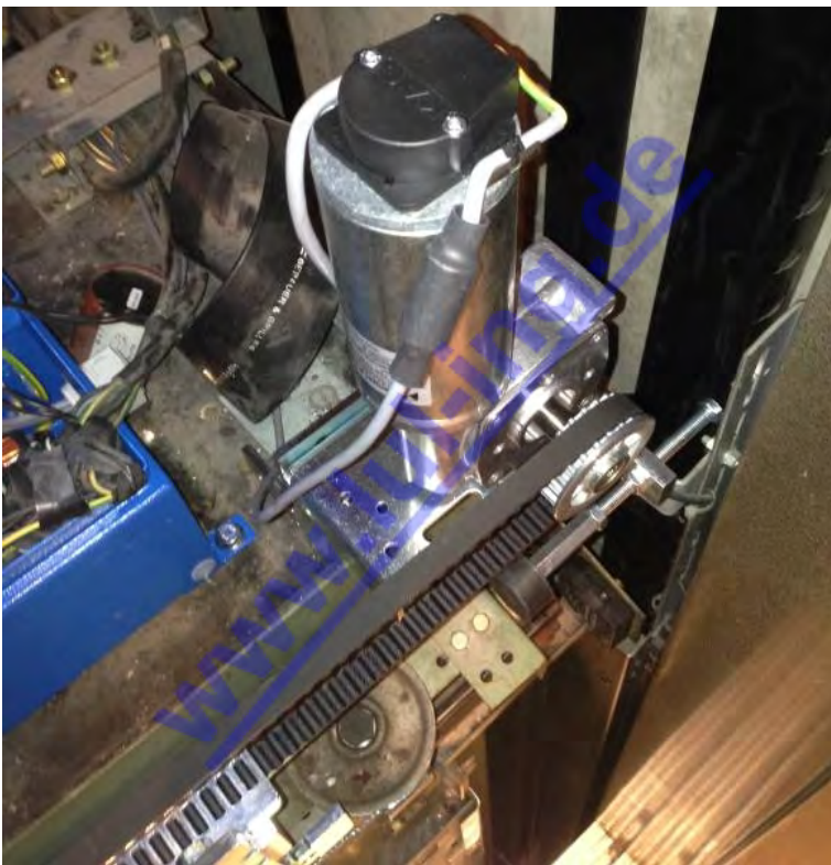
Abb. 9: TSG Antrieb - aufgebaut an Schließeseite
