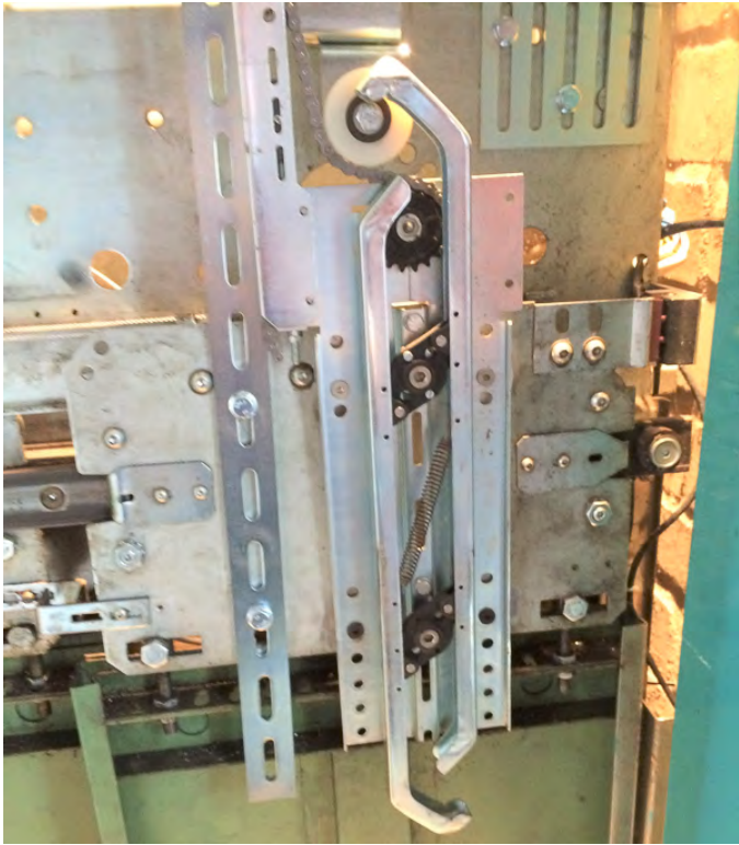
Abb. 5: TSG in Prisma Concord - Schwertbetätigung durch TSG Sinusantrieb
