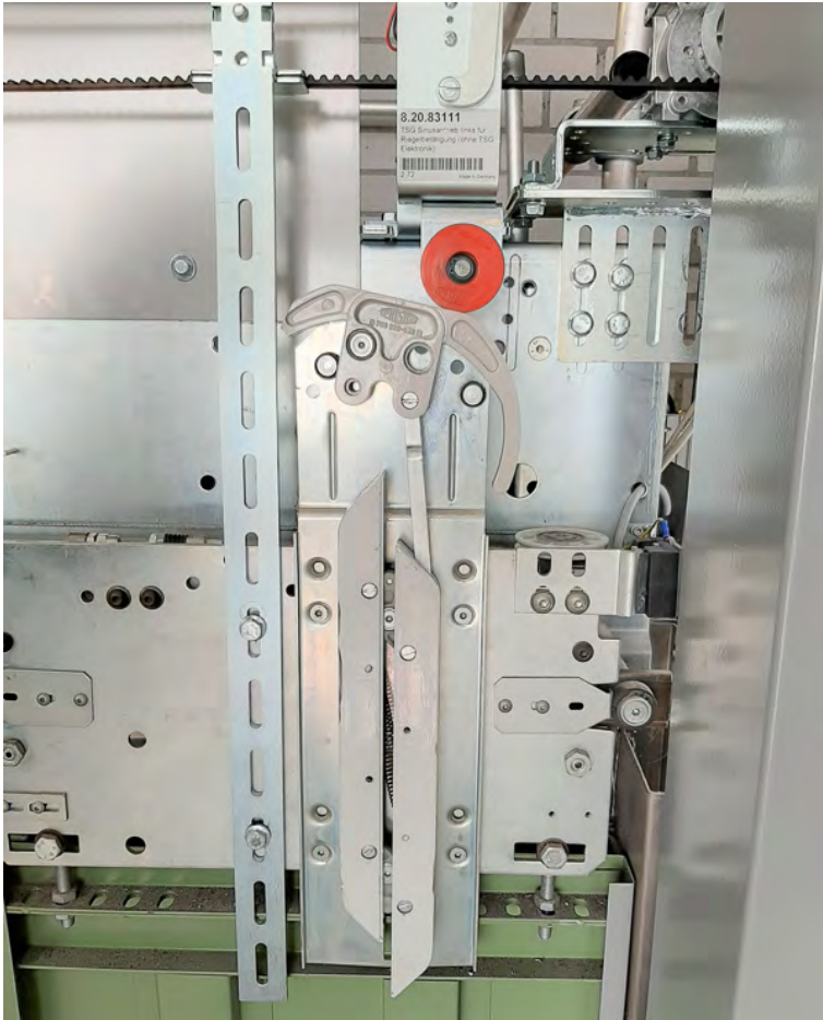
Abb. 7: TSG in Prisma Concord - Schwertbetätigung durch TSG Sinusantrieb
