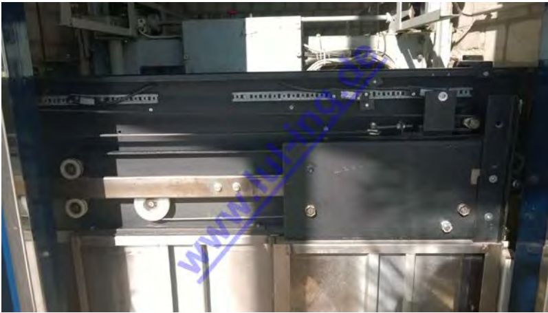
Abb. 1 Osma 2 vor dem Umbau
