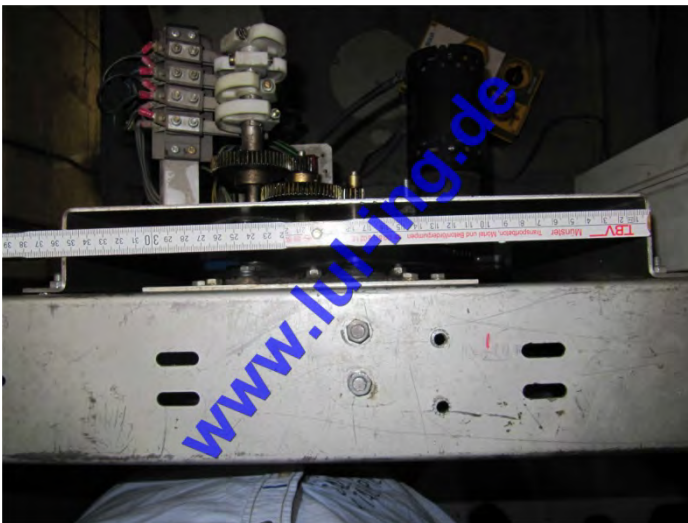
Abb. 2: Otis Vertica vor dem Umbau
