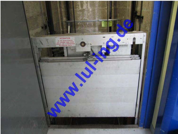
Abb. 1: Otis Vertica vor dem Umbau
