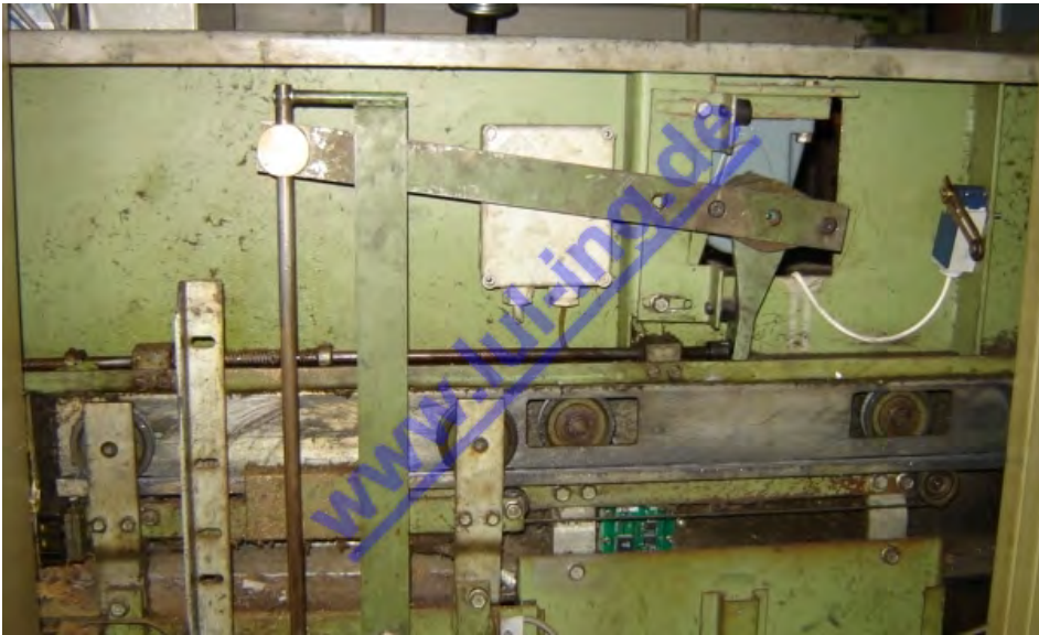
Abb. 1 MAN Tür vor dem Umbau
