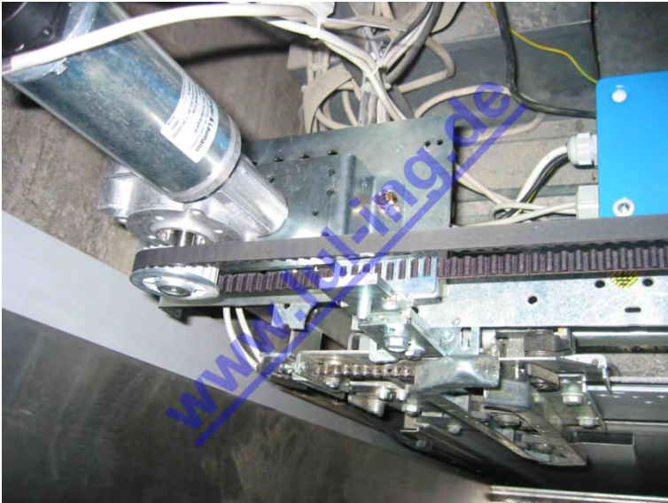
Abb. 3: TSG Antriebsseite fertig montiert in Prisma Micro, mit Spreizschwert
