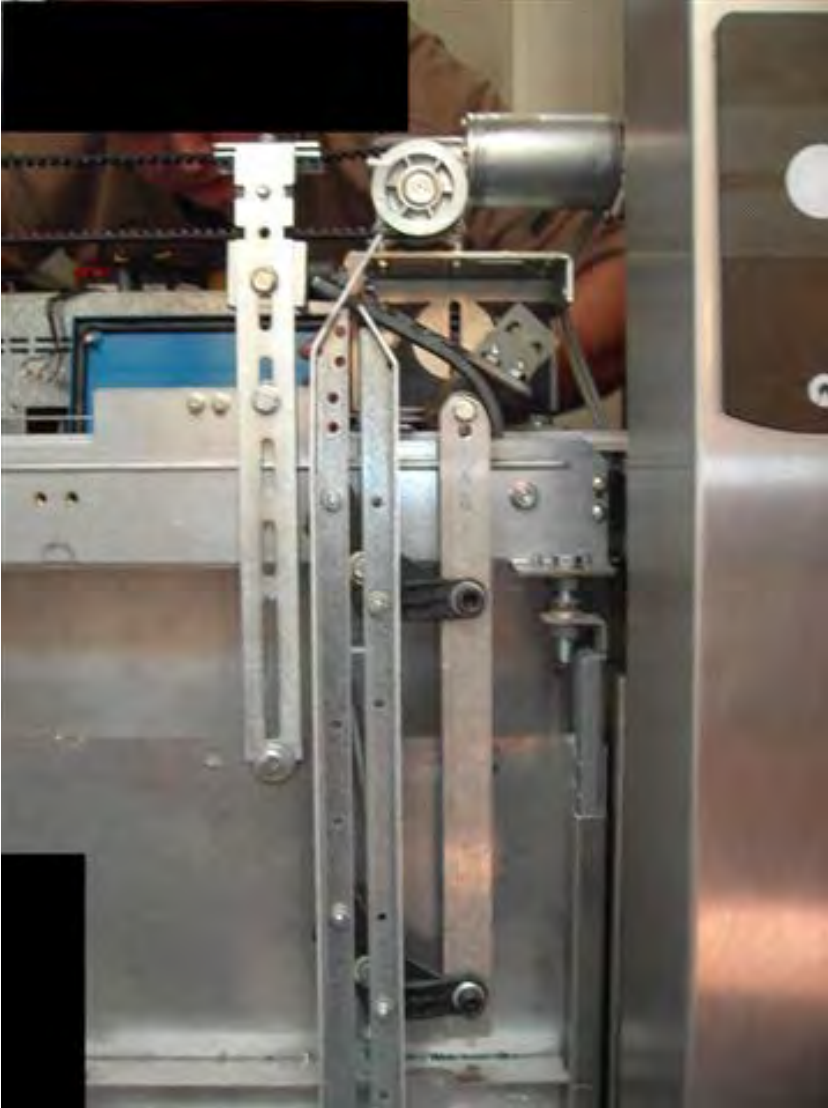
Abb. 3: Schindler Varidor10 nach dem Umbau: Spreizschwert / Türflügelmitnehmer
