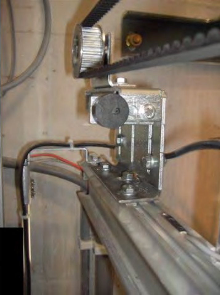
Abb. 4: Schindler Varidor10 nach dem Umbau: Gegenseite
