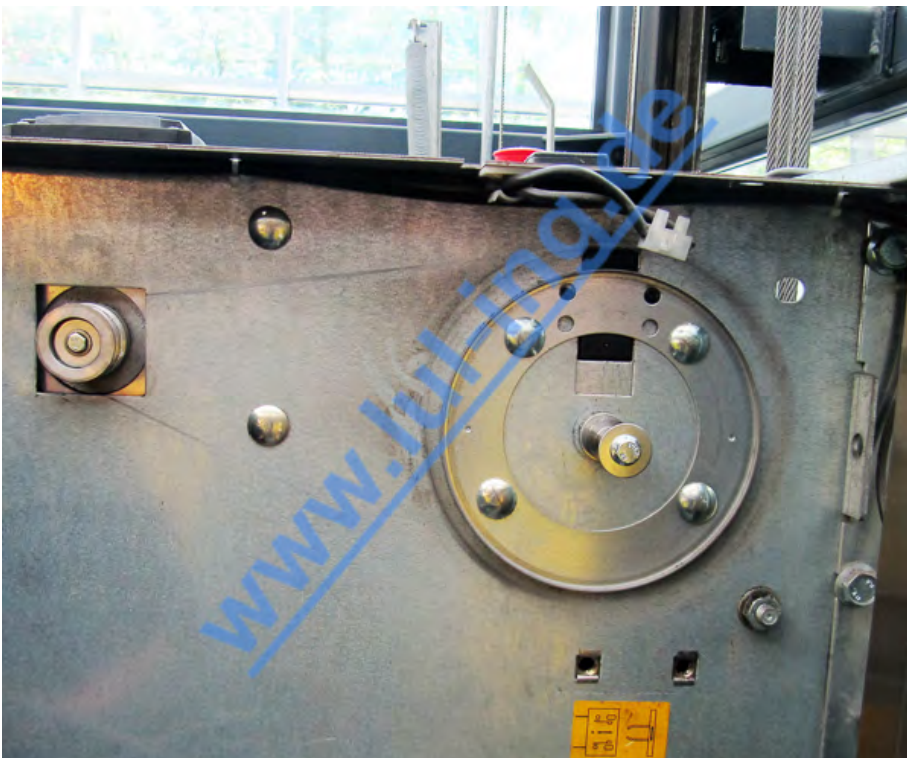
Abb. 4: demontierte Zahnriemenscheibe, montierte neue Achse
