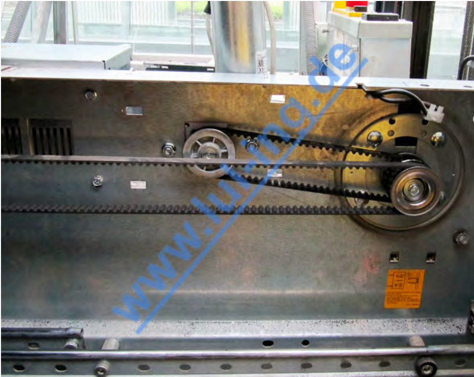
Abb. 9: fertig montierter TSG Antrieb mit aufgelegten Zahnriemen
