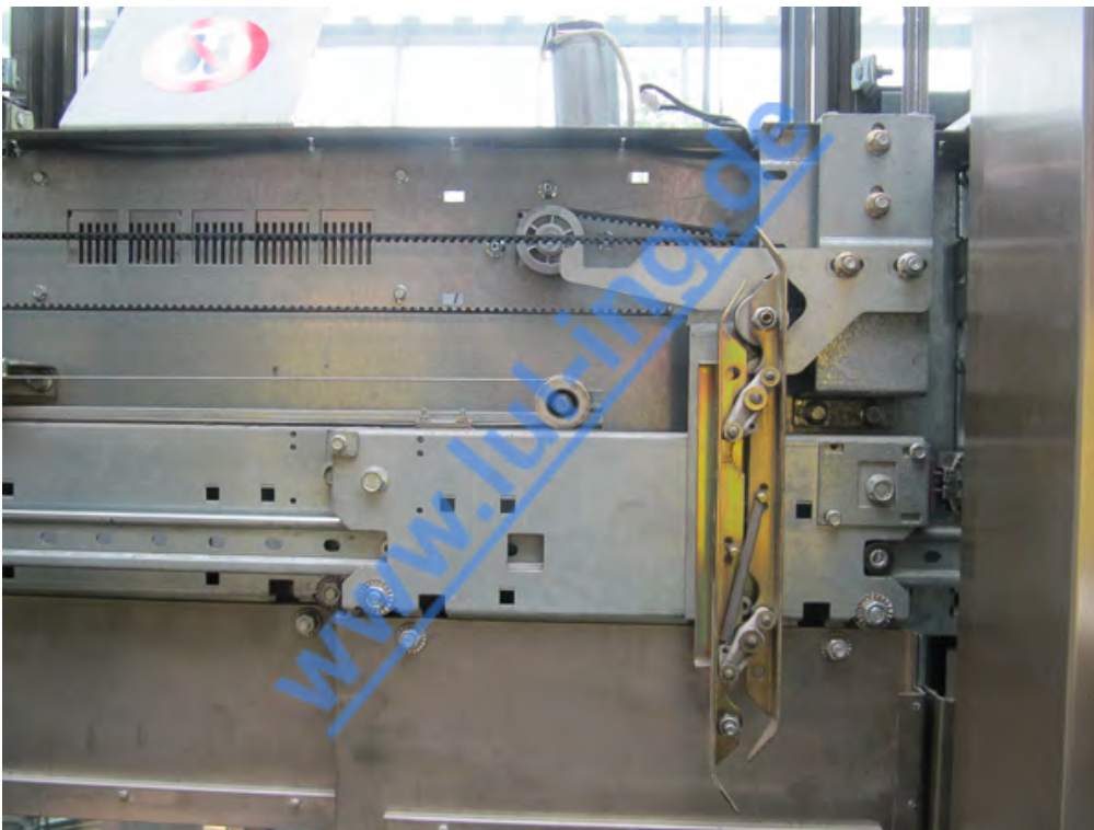
Abb. 10: fertig montierter TSG Antrieb in Schindler Varidor 50
