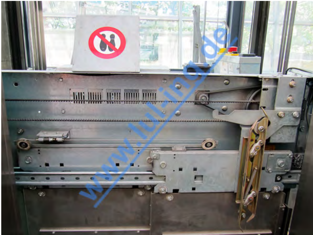
Abb. 1: Schindler Varidor 50 original (hier: teleskopierend links)
