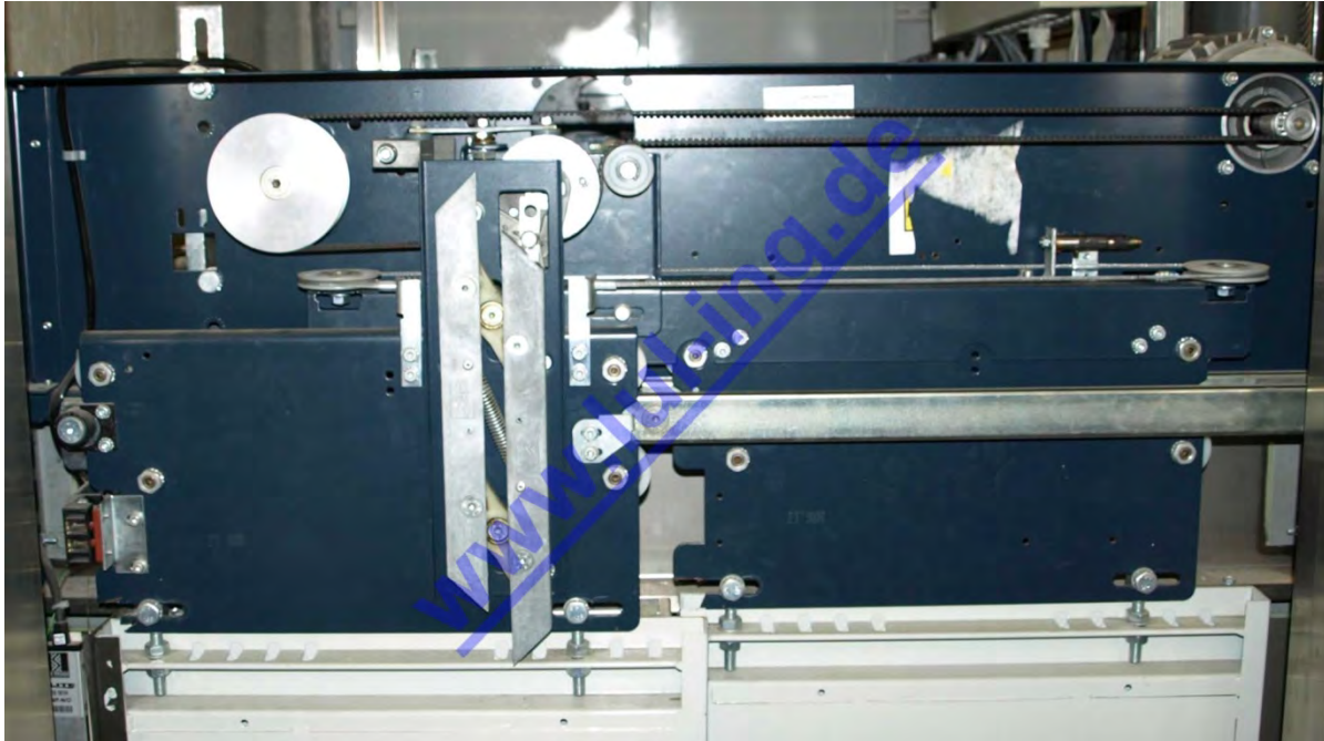
Abb. 1: Metron Türmaschine vor dem Umbau - Ansicht von vorne (hier: TL)
