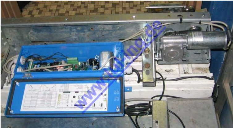
Abb. 11: TSG Antrieb fertig montiert in Türmaschine
