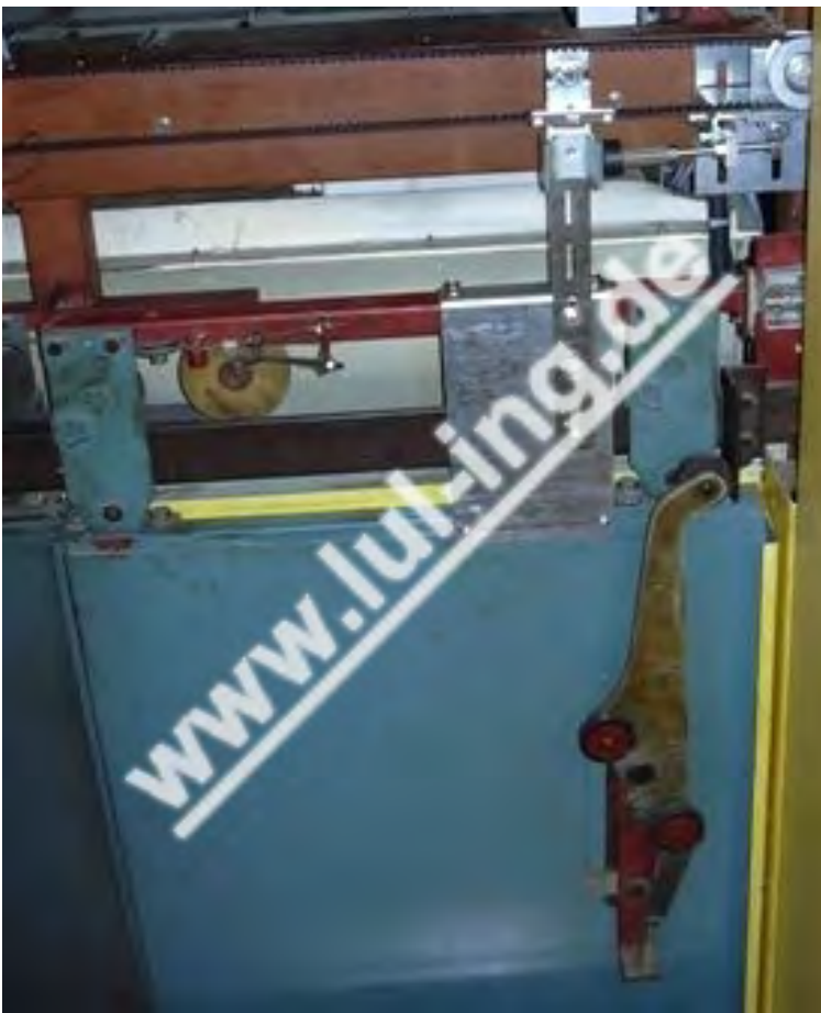
Abb. 4: Haushahn Türantrieb TS54 nach dem Umbau mit TSG
