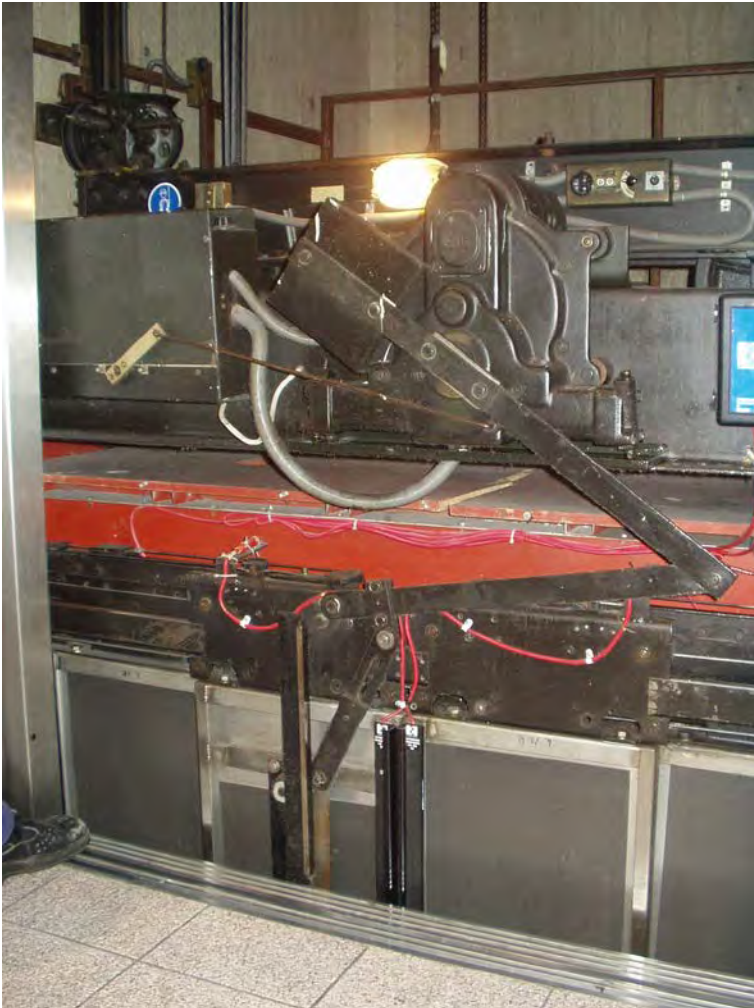
Abb. 1: Otis 6970 vor dem Umbau
