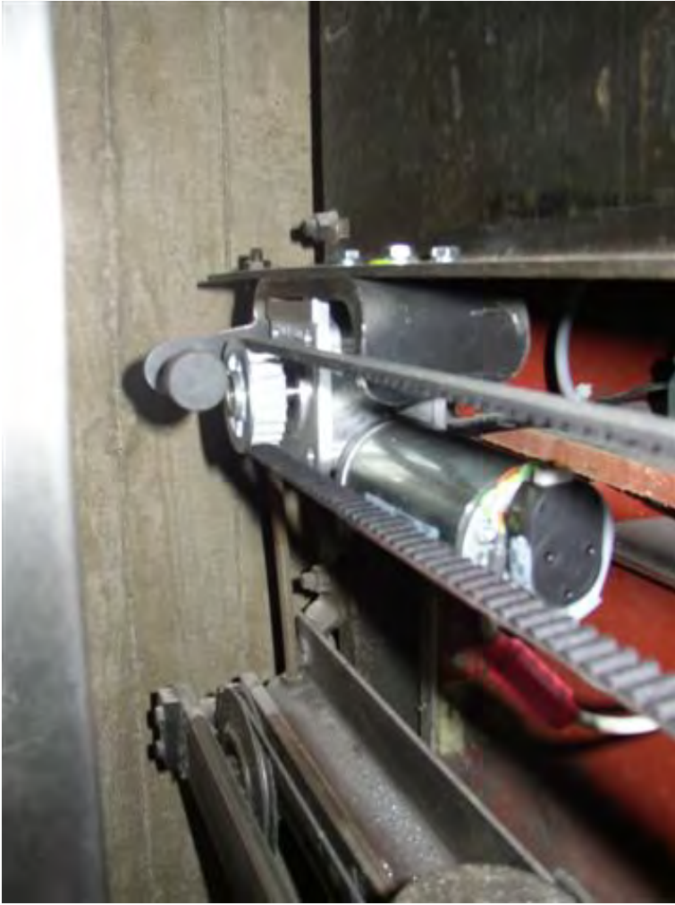
Abb. 4: Otis 6970 nach dem Umbau: Antriebsseite
