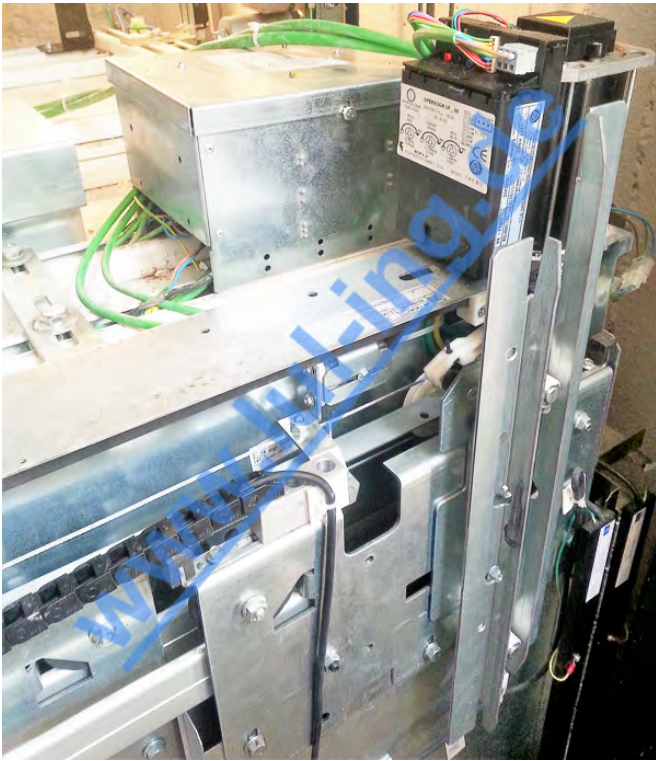
Abb. 1: Thyssen VF08 original (hier: teleskopierend links)
