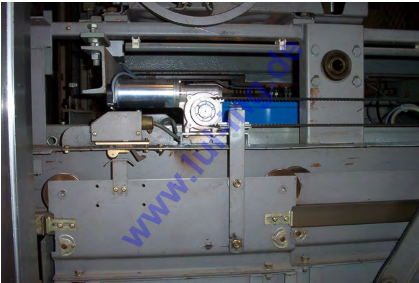
Abb. 5: Umbausatz mit Kombiwinkel „Hut“
