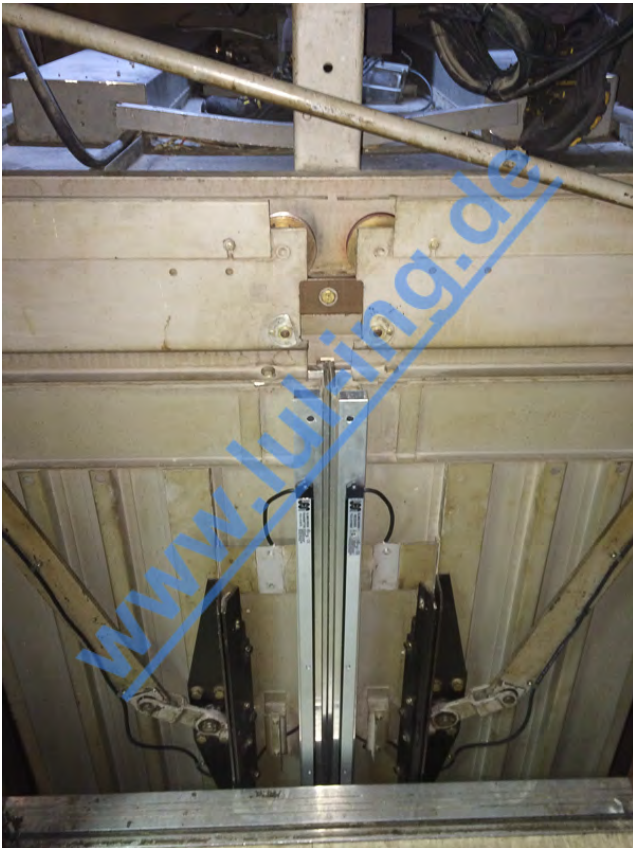
Abb. 2: Original Mitsubishi Türantrieb (hier: zentral)
