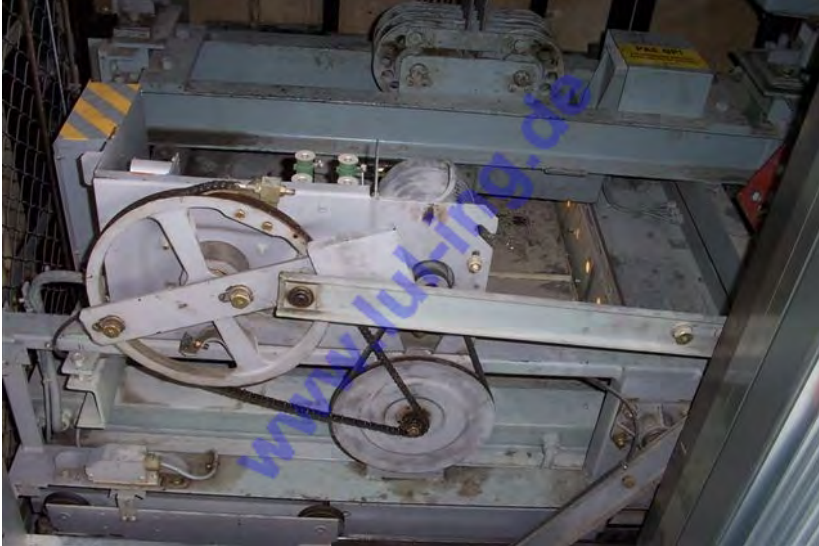
Abb. 1: Original Mitsubishi Türantrieb (hier: TR)
