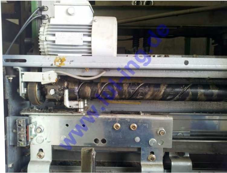
Abb. 1: Meiller TTK15 TR mit Spindel vor dem Umbau
