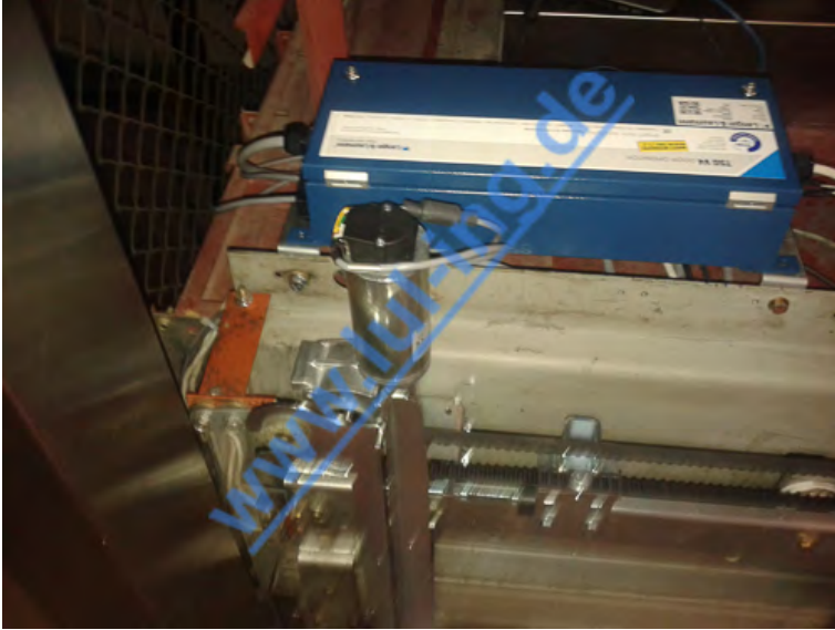
Abb. 14: TSG in Meiller TTK15, Schwertrolle
