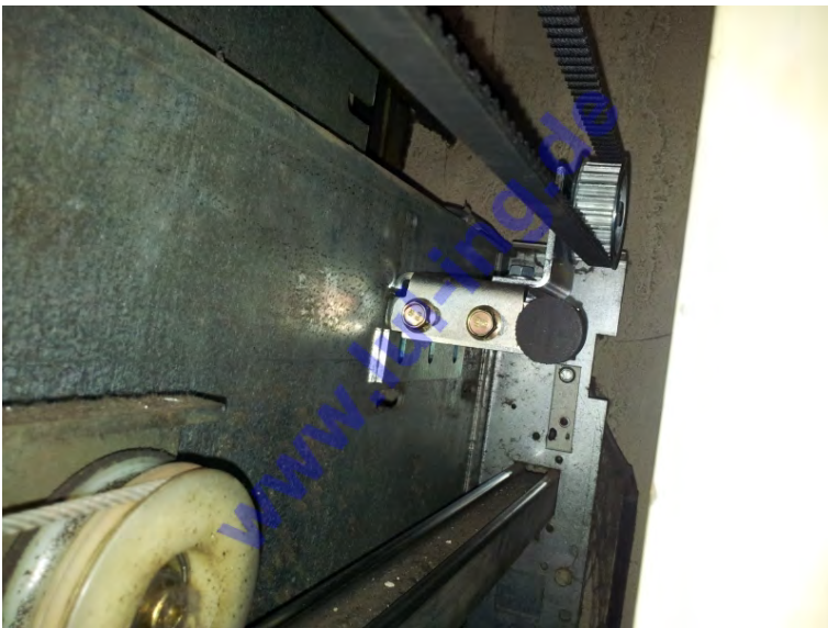
Abb. 10: TSG in Meiller TTK15, Offenseite, Endanschlag
