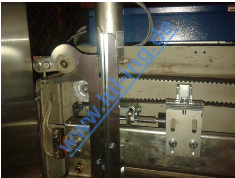
Abb. 13: TSG in Meiller TTK15, Schwertrolle
