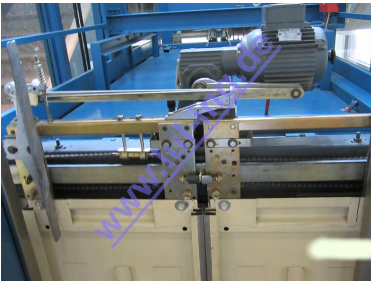
Abb. 2: Sematic III DC, zentral öffnend
