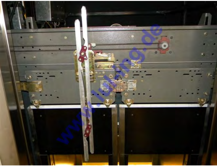
Abb. 1: Fermator Tür vor dem Umbau
