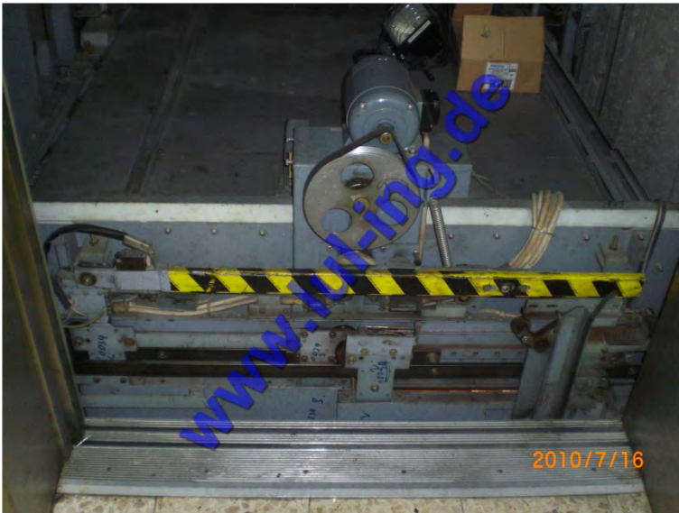
Abb. 1: Kone OAK vor dem Umbau
