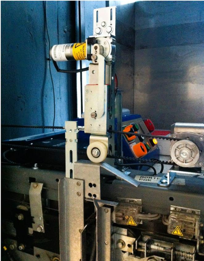
Abb. 8: TSG Sinusantrieb in Thyssen M2Z D6
