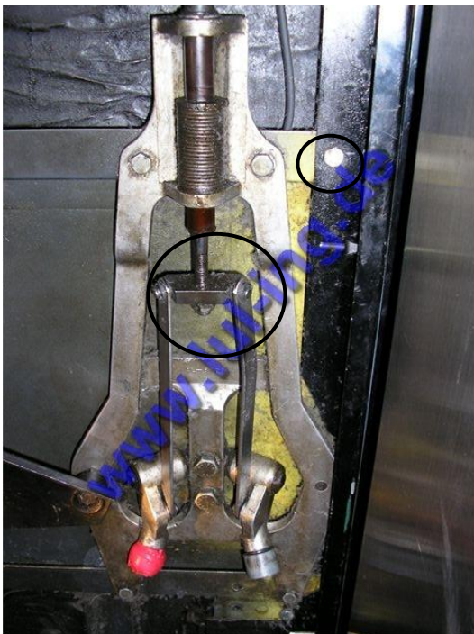
Fig. 12: Ancien dispositif d'entraînement de porte palière à l'état monté
