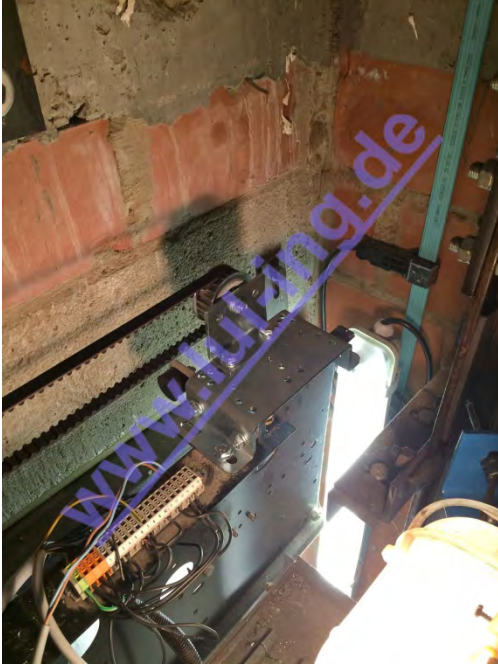
Fig. 5: TSG guide roller
