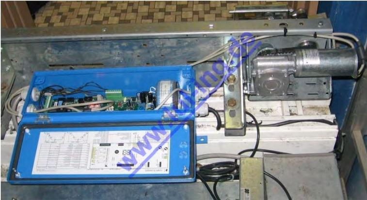
Img. 11: L'entraînement TSG assemblé sur l'opérateur de porte
