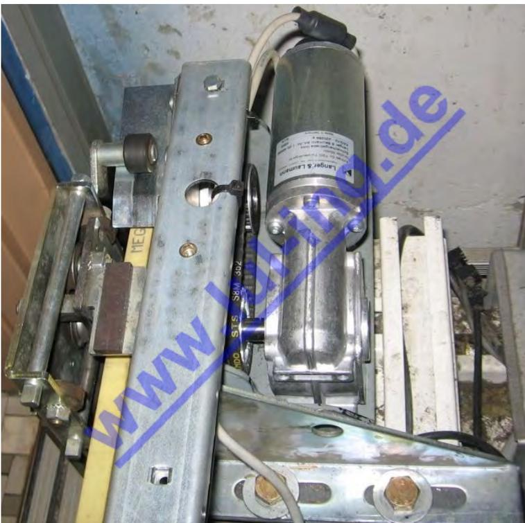
Img. 12: L'entraînement TSG assemblé sur l'opérateur de porte
