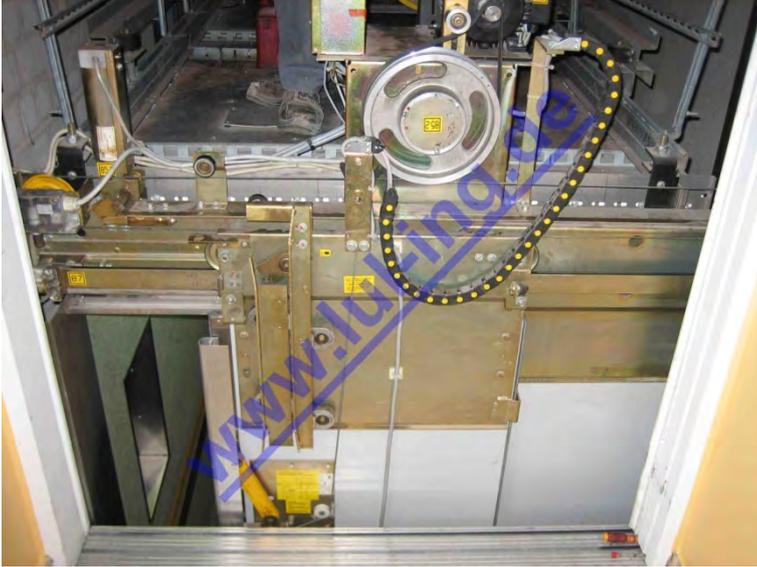
Abb. 1: KONE ADC avant la reconstruction (ici: KONE ADC2, télescopique ouverture à droite)
