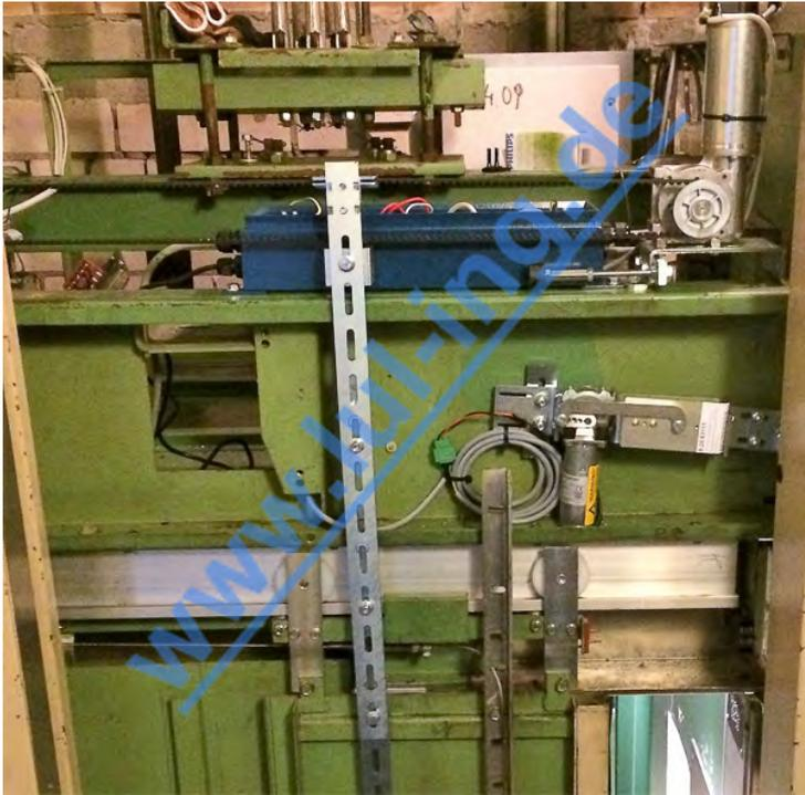
**Abb. 14: Beispiel Sinusantrieb direkt am Riegel montiert**
