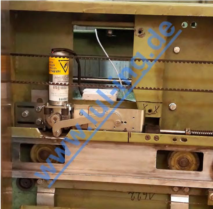
**Abb. 9: Beispiel für die Montage des TSG Sinusantrieb**
