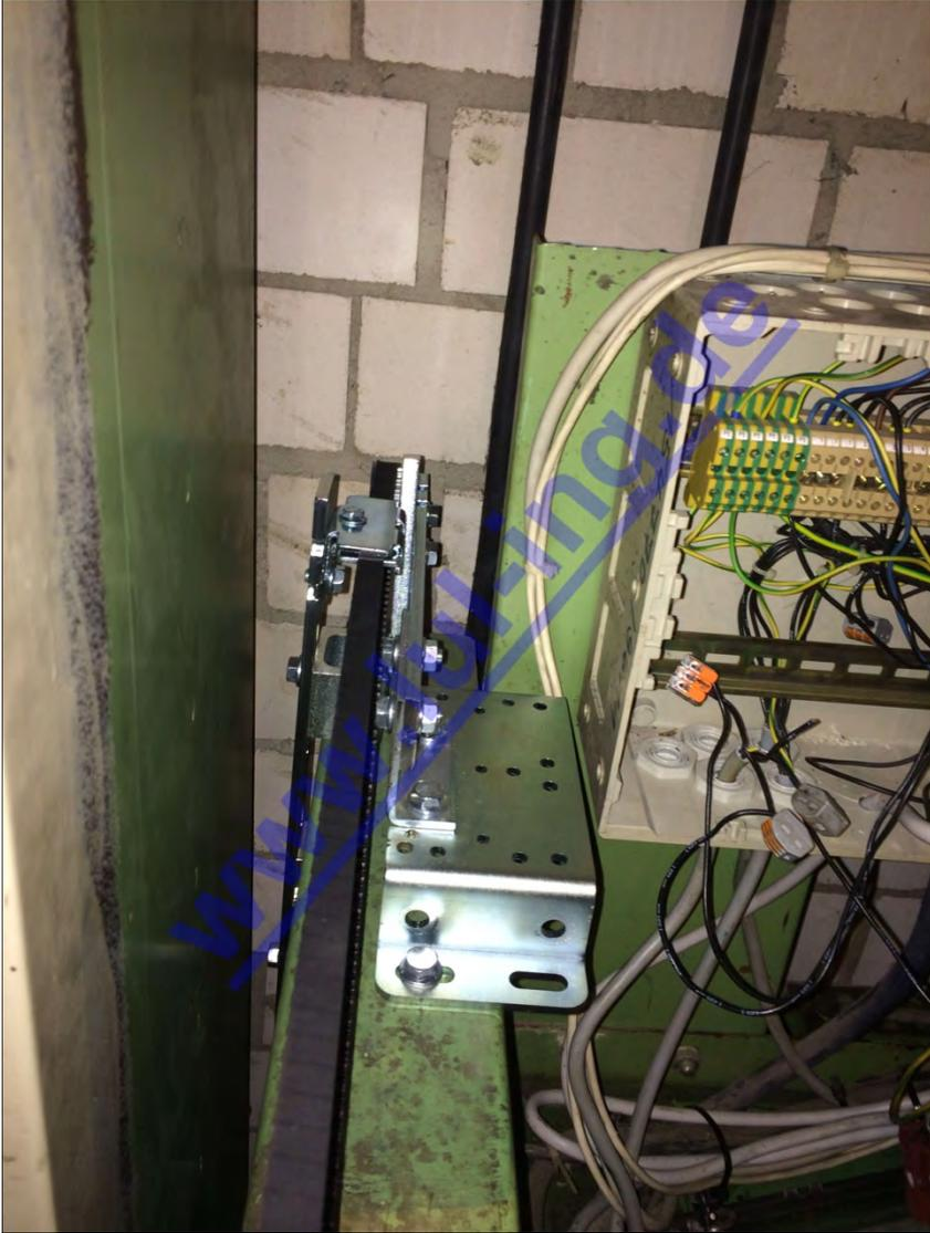
Abb. 11: TSG Umlenkrolle mit Hutwinkel
