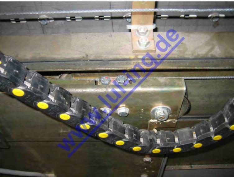
Abb. 6: langsamer Türflügel mit Drahtseil
