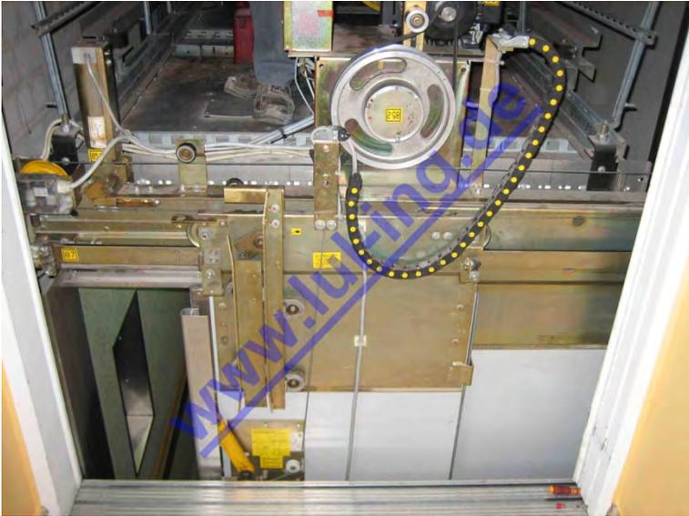
Abb. 1: KONE ADC vor dem Umbau (hier: KONE ADC2, TR)
