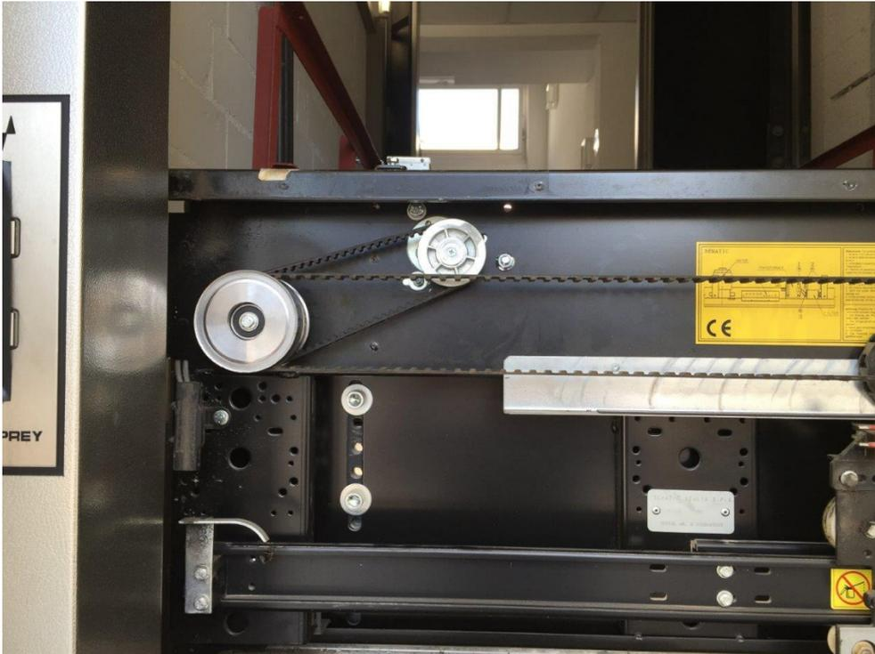
**Fig. 16: opérateur de porte TSG complètement monté**
