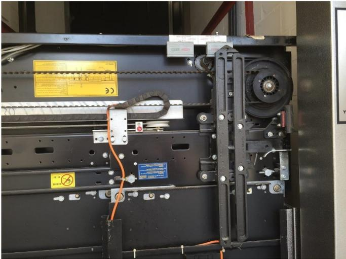
**Fig. 1: Sematic 900H avant la reconstruction: ouverture gauche**
