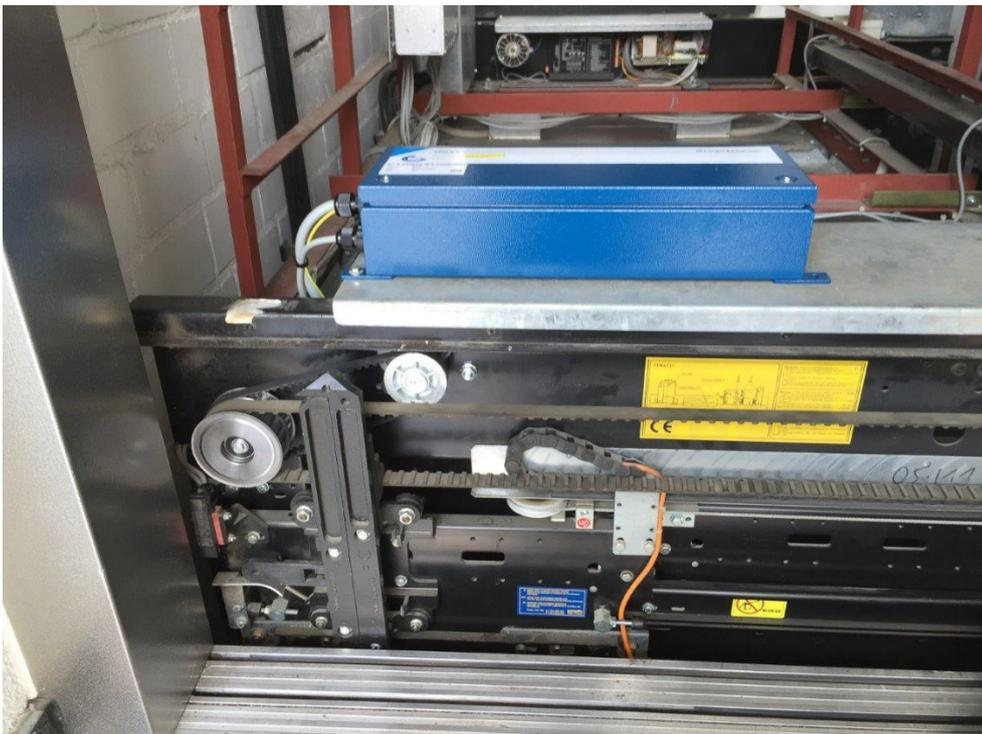
**Fig. 17: opérateur de porte TSG complètement monté**
