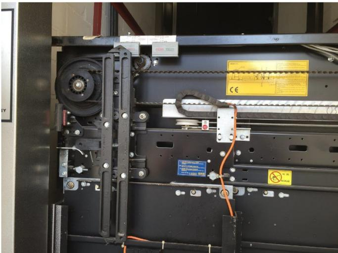
**Fig. 2: Sematic 900H avant la reconstruction: ouverture droit**
