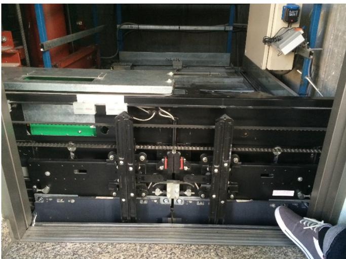
**Fig. 3: Sematic 900H avant la reconstruction: ouverture central**
