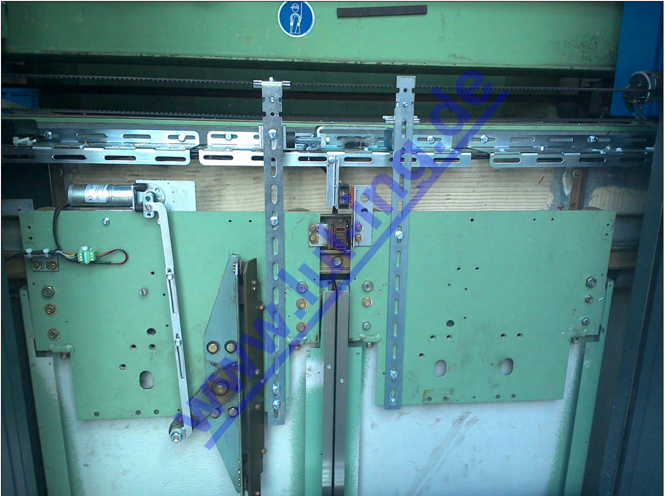
Abb. 6: umgebaute Otis OVL Zentral
