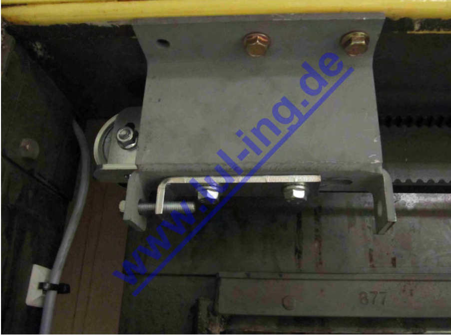
Abb. 5: TSG in Peignen Schachttür - Halterung Gegenrolle mit Spannstation
