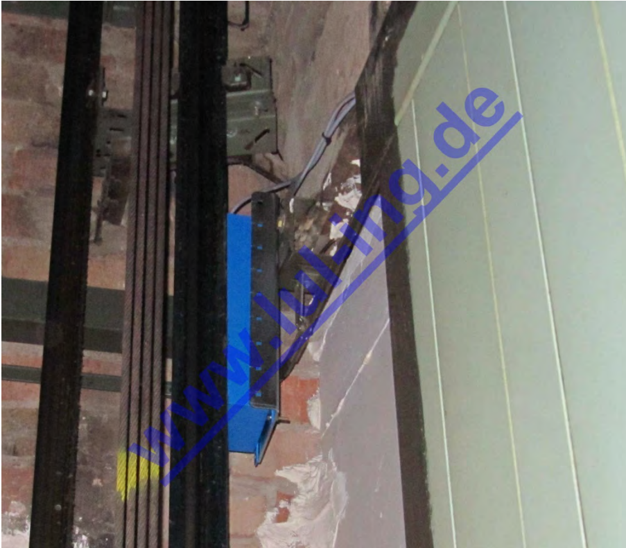
Abb. 7: TSG in Peigen Schachttür - Befestigung TSG Elektronik im Schacht
