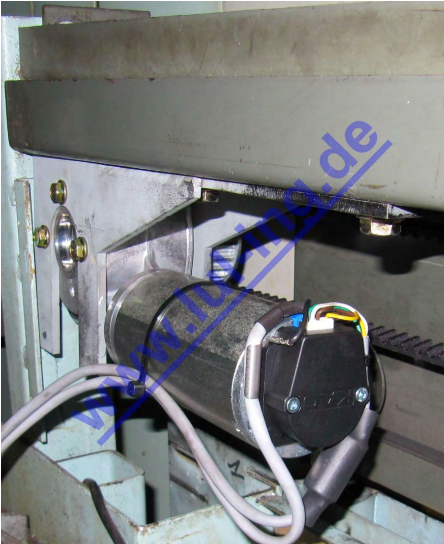
Abb. 9: TSG in Peignen Kabinentür - Motorhalterung
