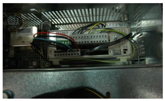
Abb. 4 Lust door operator without LON bus
