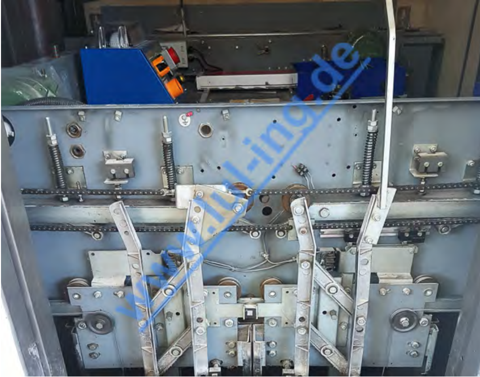
Abb. 1: Orona Kette original (hier: zentral öffnend)
