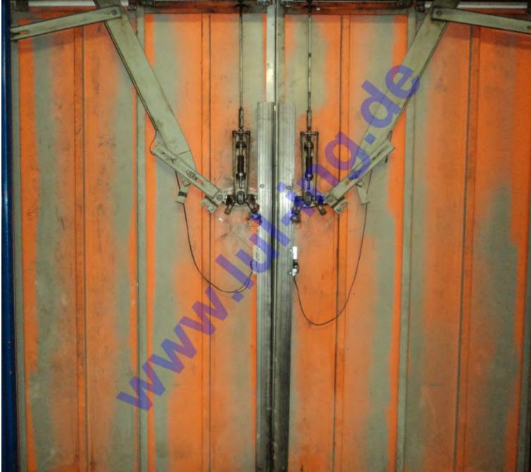
Abb. 3: original Schindler QKS6 / QKS7 Kabinentür ZT
