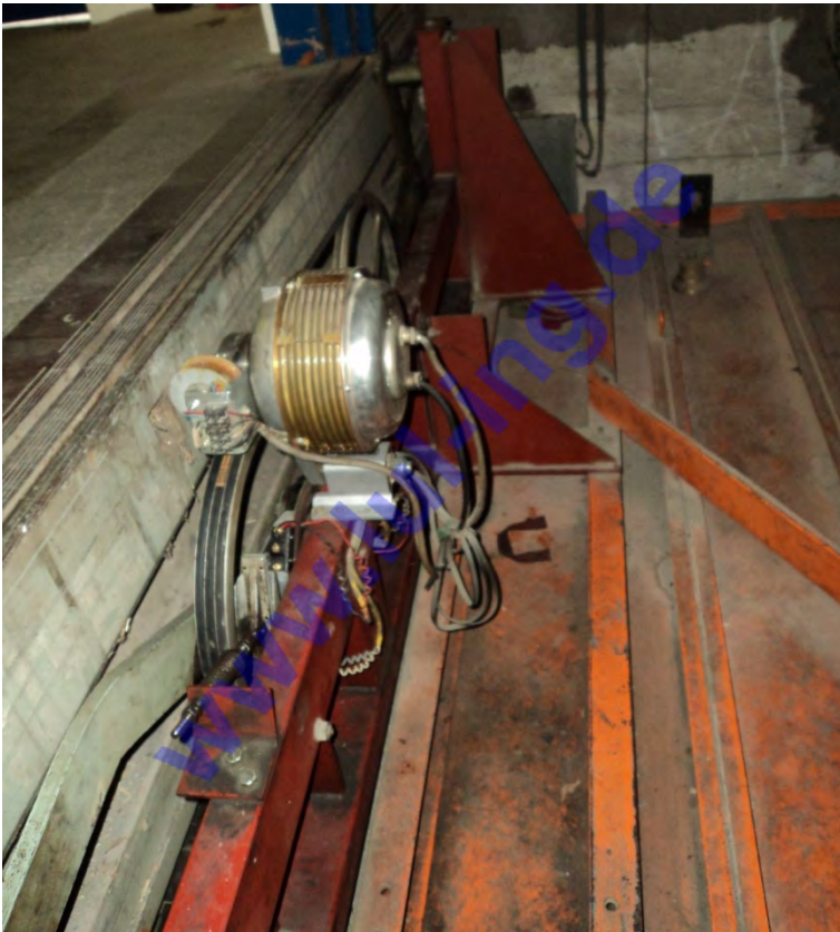
Abb. 1: original Schindler QKS6 / QKS7 Türmaschine ZT
