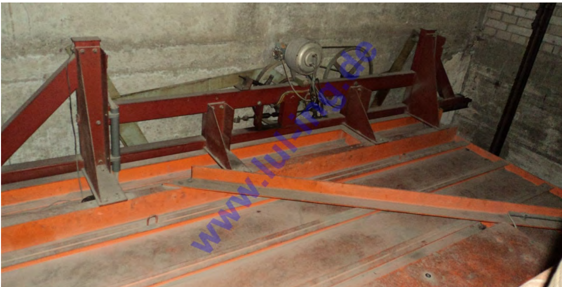
Abb. 2: original Schindler QKS6 / QKS7 Türmaschine ZT
