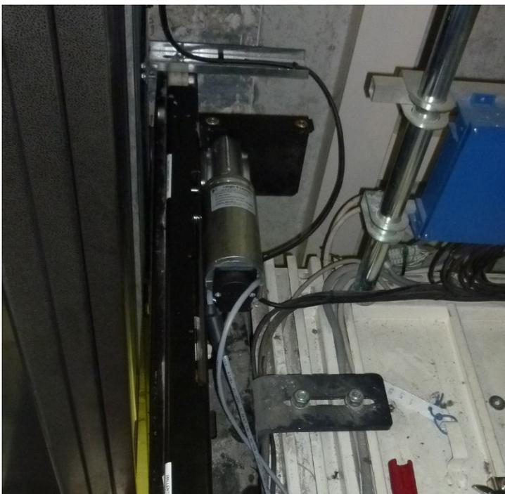
**Abb. 19: fertig montierte Türmaschine mit TSG (zentral öffnend)**
