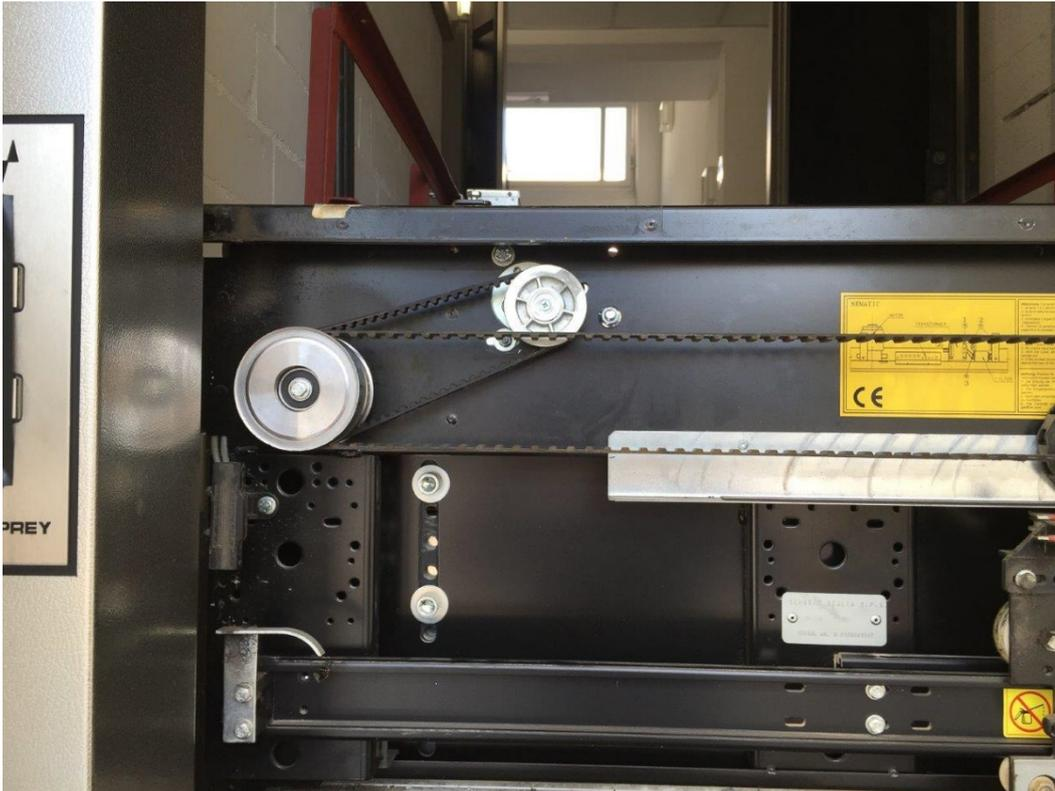
Abb. 16: fertig montierte Türmaschine mit TSG (teleskopierend rechts öffnend)
