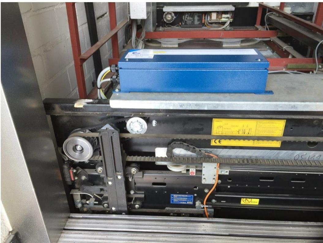
Abb. 17: fertig montierte Türmaschine mit TSG (teleskopierend rechts öffnend)
