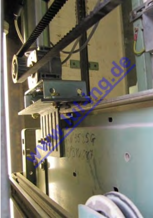
Fig. 3: Vue de l'opérateur TSG
