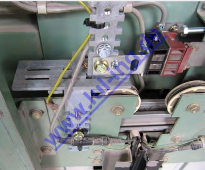
Fig. 9: Entraînement des vantaux de porte du TSG
