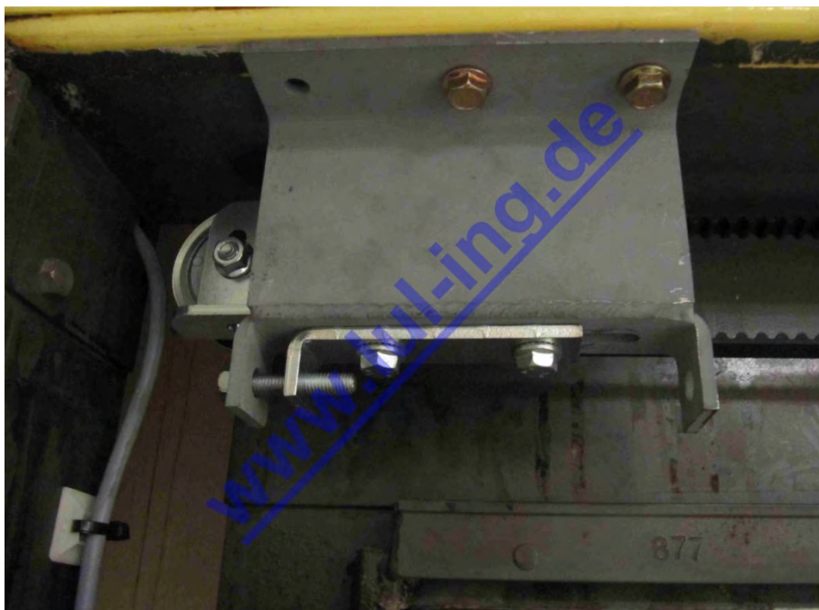
Img. 5: Peignen A30 remplacée par le TSG, Support poulie avec system de serrage
