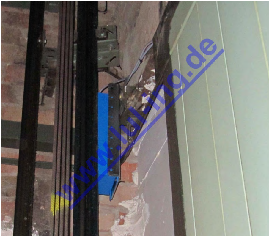
Img. 7: Peignen A30 remplacée par le TSG - Fixation électronique du TSG
